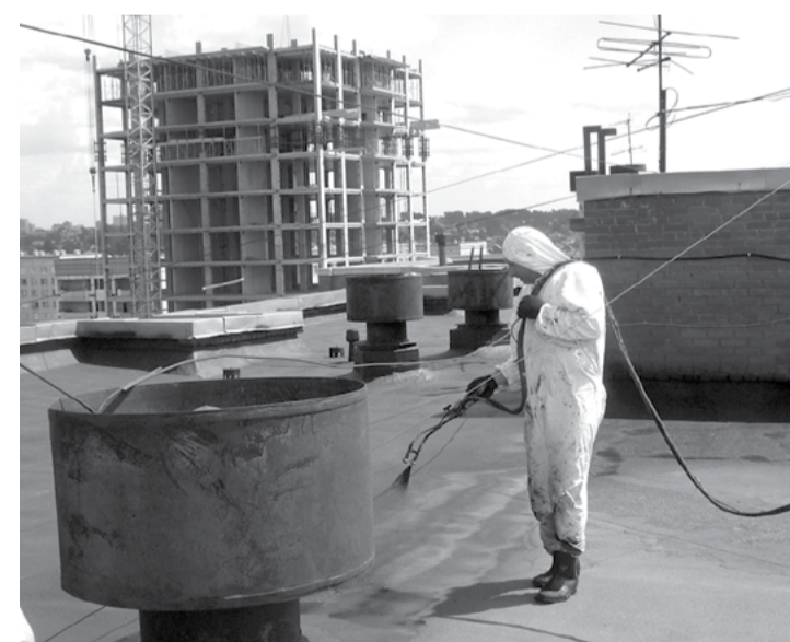
Объект в Кемерово где уже произведены и сданы работы по нанесению жидкой кровли, ул. Сибиряков-Гвардейцев 24 (ТСЖ «Гудок»)
