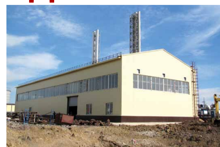
Строится автоматическая паро-водогрейная котельная производительностью 57 МВт для Яйского нефтеперерабатывающего завода, предназначенная для технологического пароснабжения и снабжения теплофикационной водой для отопления и горячего водоснабжения (Кемеровская область, Яйский район). Основное топливо — осушенный топливный газ от технологических установок, резервное топливо — мазу. Предусмотрена возможность работы котельной на атмосферном газе и дизельном топливе
