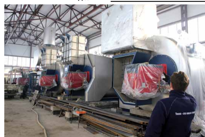
Процесс производства работ по монтажу крупногабаритного технологического оборудования в котельной Яйского нефтеперерабатывающего завода
